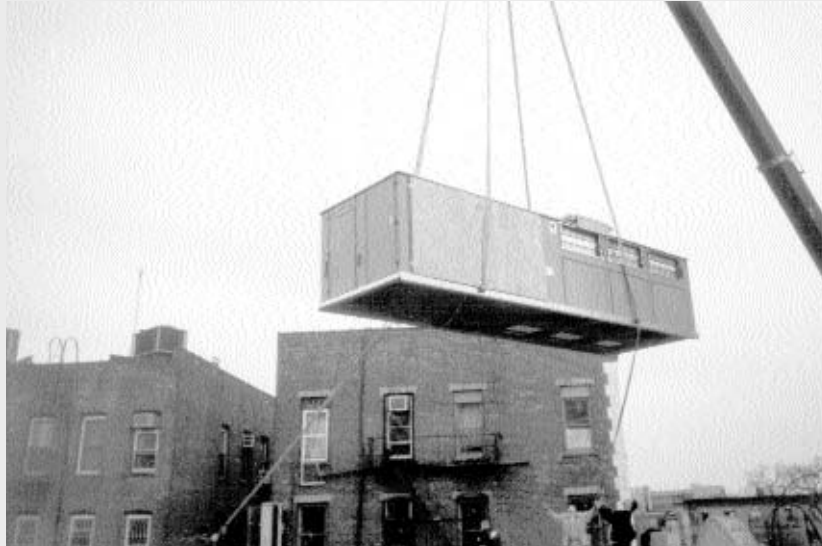
מנוף ענק מניח את מערכת המיזוג החדשה על גג 770
